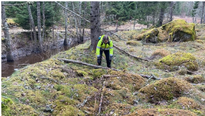
Figur 31. Fotot visar hur rensvallarna ser ut. En stor del av sträckan är kraftigt fördjupad och kanaliserad.
