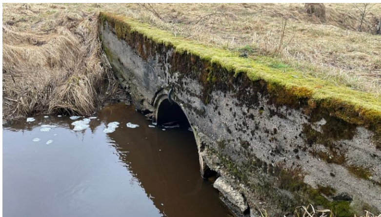
Figur 38. Trumman, sedd uppströms ifrån, är ingjuten i betong på övre sidan.
