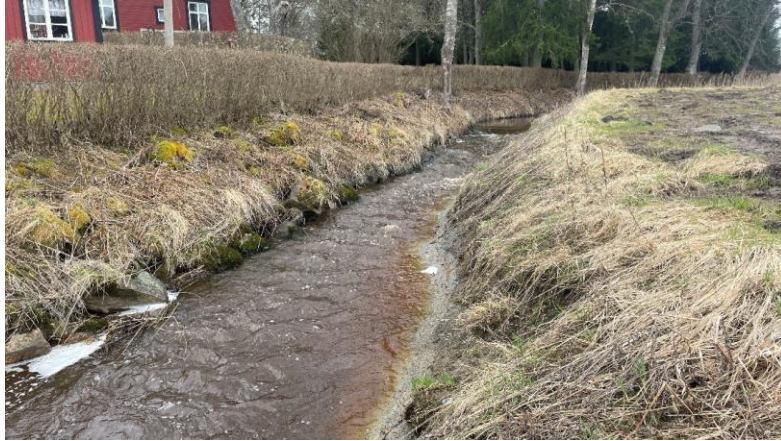
Figur 13. Sträcka 2 domineras av lera men det förekommer även en del bortrensad sten längs vattendragets sidor som vid denna rensade bestämmande sektion.
