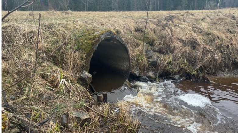
Figur 37. Trumman i början av sträcka är för högt placerad vilket skapar en fri ände som gör det svårt för fisk att passera.
