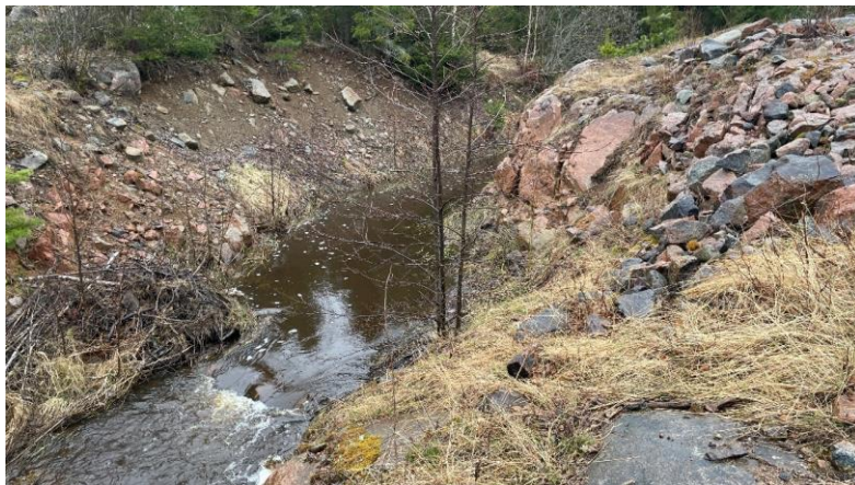
Figur 41. Sprängning av bergsklackar har skett på sträckan.
