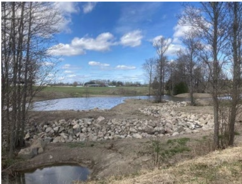
Nyanlagt omlöp (fiskväg) i Lötbäcken med omgivande små fosfordammar
