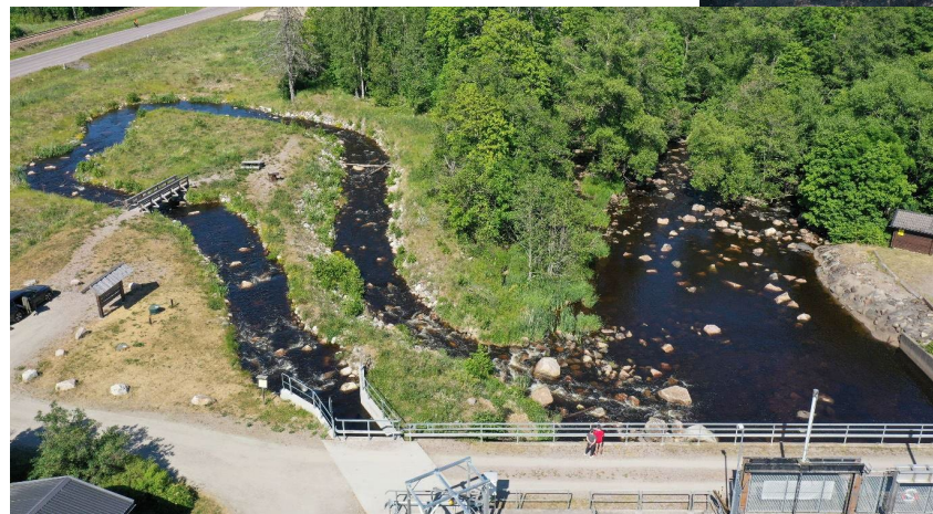
Östtuna kraftstation, omlöp
