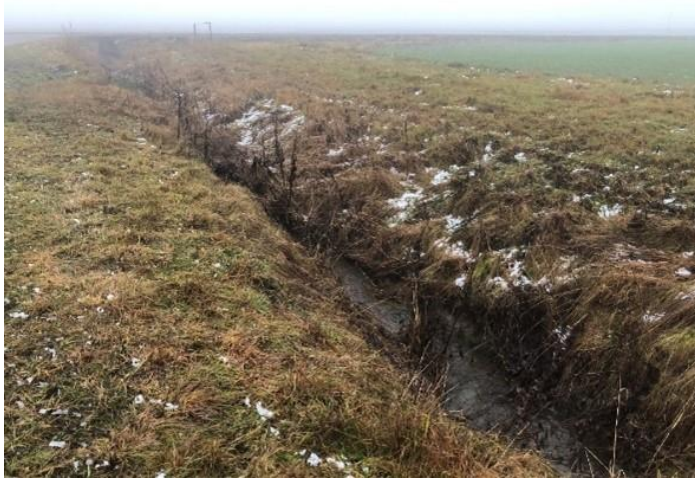
Bild 11. Dike som kulverterades, Svepnäs
