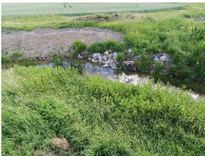
Bild 15. Erosionsskydd i Varmsätrabäcken
