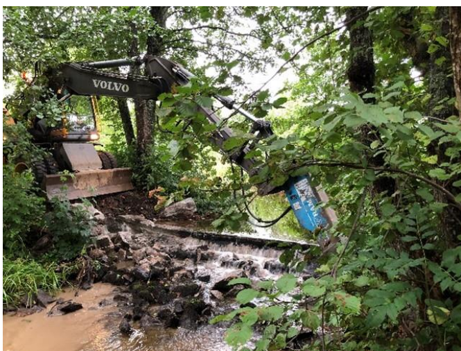
Bild 7. Damm under utrivning
