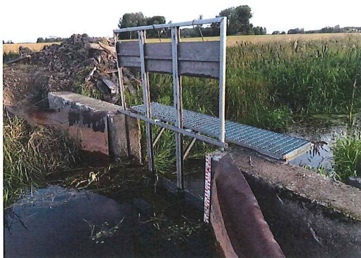
Dammen där Gussjöns nivå regleras.
