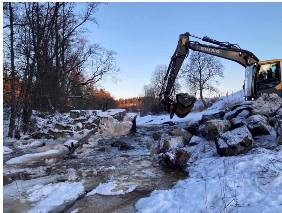
Korslöt, Köping, efter åtgärd
