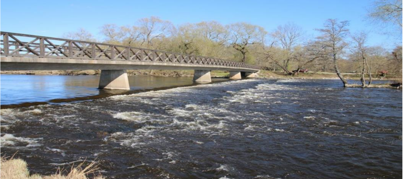
Figur 1 Dammen vid Ridhusbron, Kolbäcksån.
