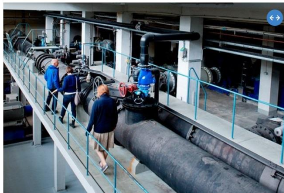
Lövö vattenverk på Ekerö. Det tar tolv timmar för vattnet att gå igenom reningsprocessen. Foto: LLARS PEHRSON
