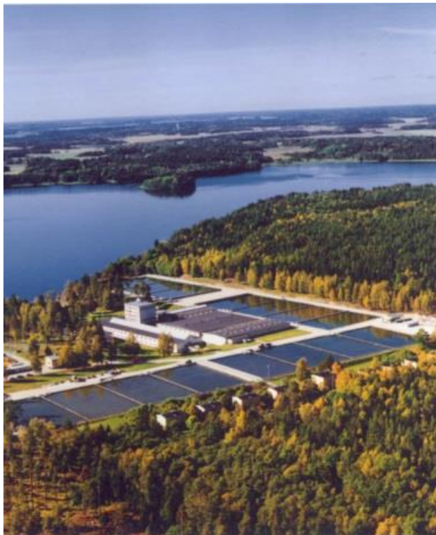
Bild 1: Lovö vattenverk tar sitt råvatten från Mörbyfjärden på den nordvästra sidan av Lovön i Ekerö kommun och renar Mälarens vatten tillsammans med Norsborgs vattenverk (Stockholm Vattens andra anläggning) för över en miljon invånare. Foto: Stockholm Vatten.
