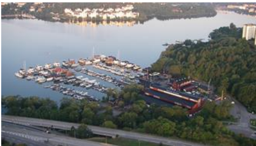
Bild 24: Vid den årliga upptagningen av båtarna i Pampas Marina i Solna undersöks det utgående vattnet från båtvätsanläggningen för metaller och TBT. Se Pampas Marina båtvätsstudier 2007-2012 (Solna Stad) på nästa sida. Foto "Pampas Marina" av Haxpett; CC BY-SA 3.0 via Wikimedia Commons.
